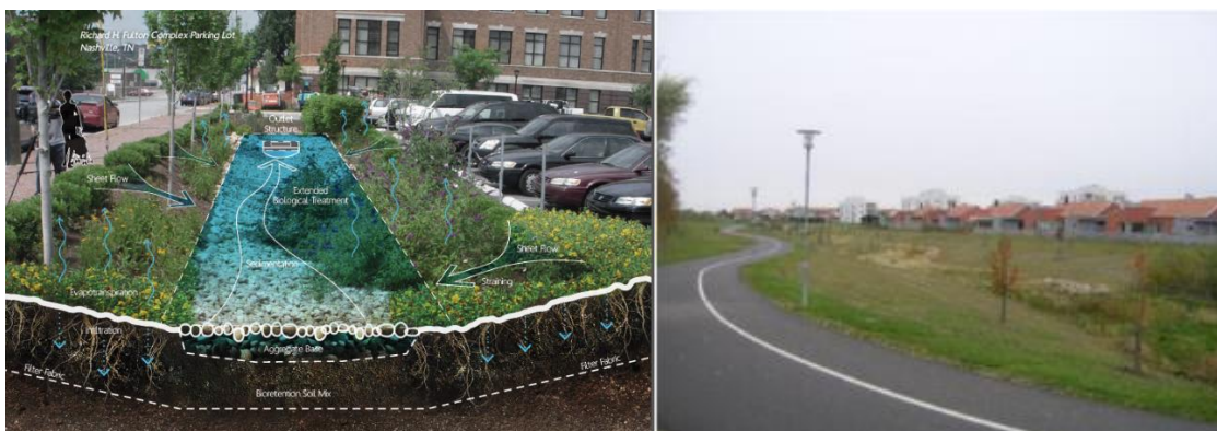
Figur 11. Exempel på växtbädd respektive grönstråk (i detta fall i kombination med svackdike) för fördröjning och naturlig rening av dagvatten. Även ”renodlade” svackdiken kan tillämpas i anslutning till vägar och gator. Källa: Aalto-universitet., Sweco.
