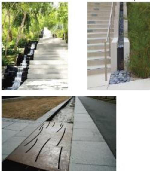
Figur 10. Exempel på ytliga avledningsåtgärder (rännor/kanaler). Källa: Sweco.
