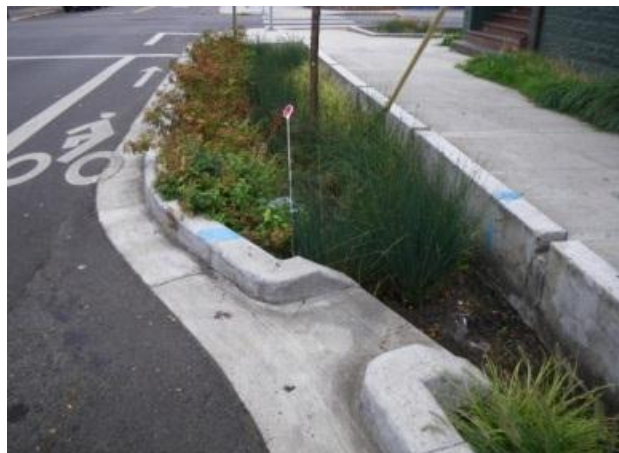
Figur 6. Exempel på kantstenslösningar (curb extensions) i Portland, USA. Denna lösning innefattar ett s.k. "kantstenssläpp" för att leda vattnet mot biofiltret. Foto: Sweco.
