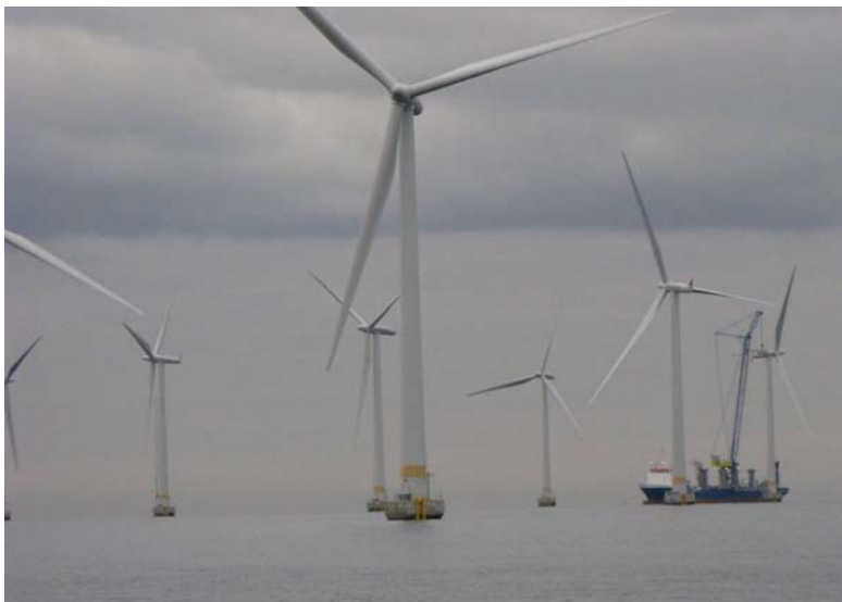
Montering av vindkraftverk till havs (Lillgrund)
