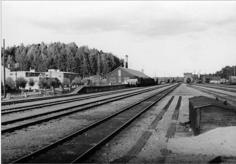
Söderhamns bangård när den var som störst vid mitten av 1900-talet. Mitt i bilden syns godsmagasinet och till höger syns lokstallet. Foto: okänd, ur Järnvägsmuseets bildarkiv.
