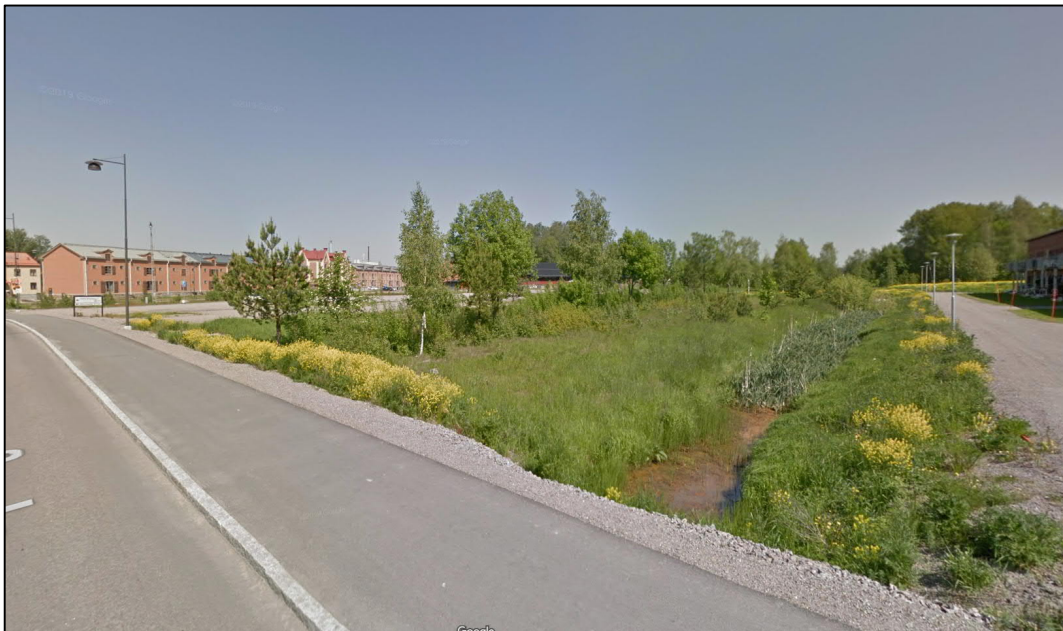
Foto 2. Dike som avgränsar området i öst.
