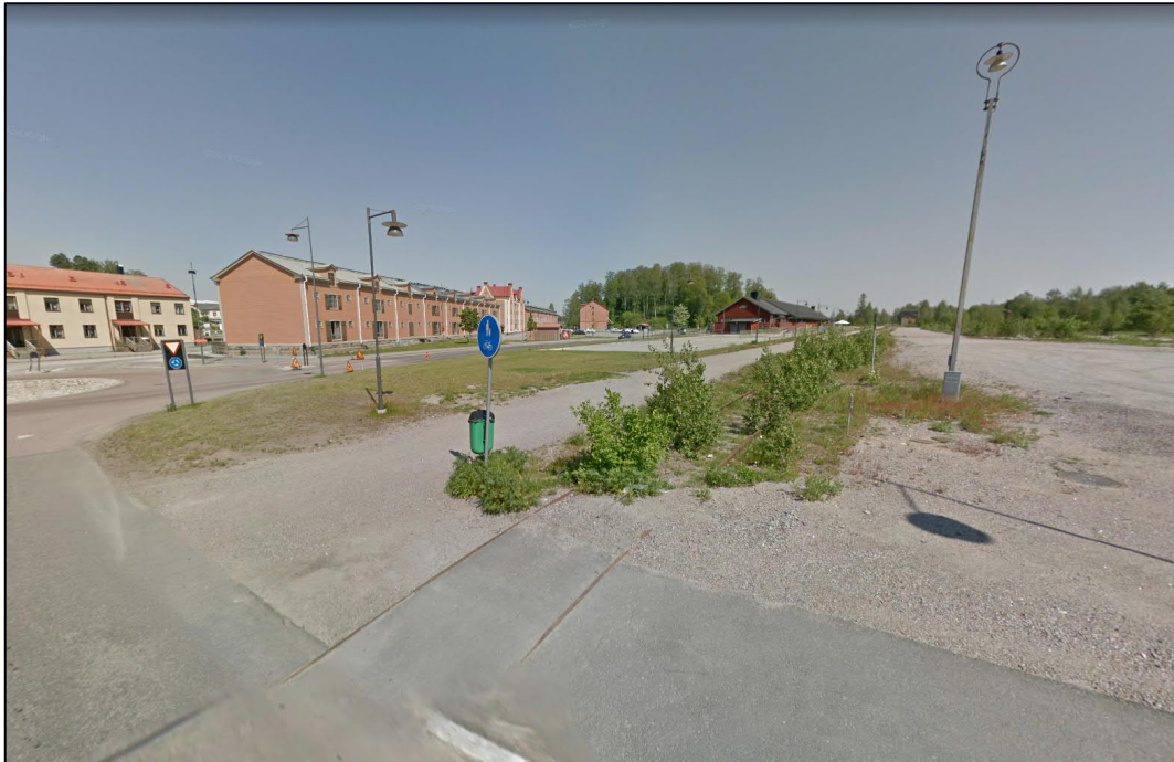
Foto 1. Godsmagasinet med den gamla rälen synlig i bild.
