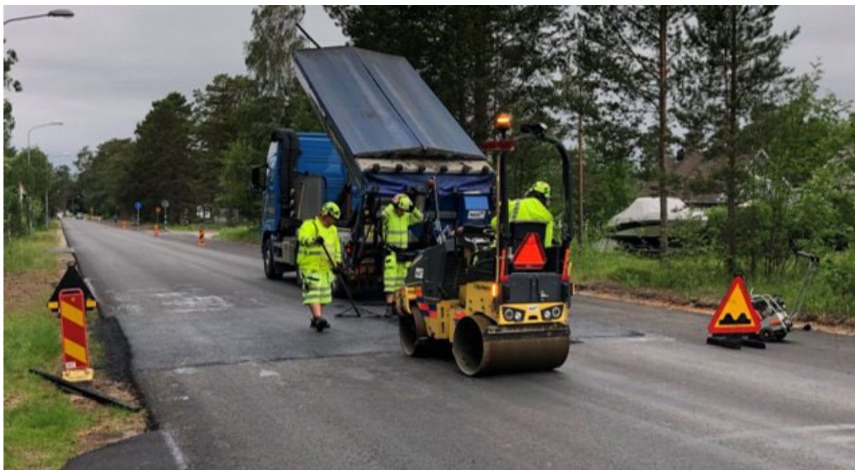
Förseglad beläggningsskarv
